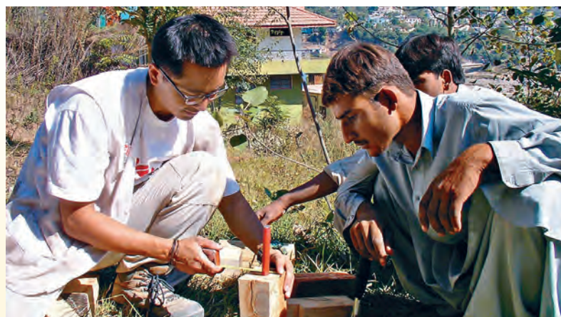
■在2005年喀什米爾地震後，高永賢博士、工程師教授當地居民利用有限的工具和材料來修復和重建避難所，為受影響的居民提供居住、貯存及作救援之用的場所。
